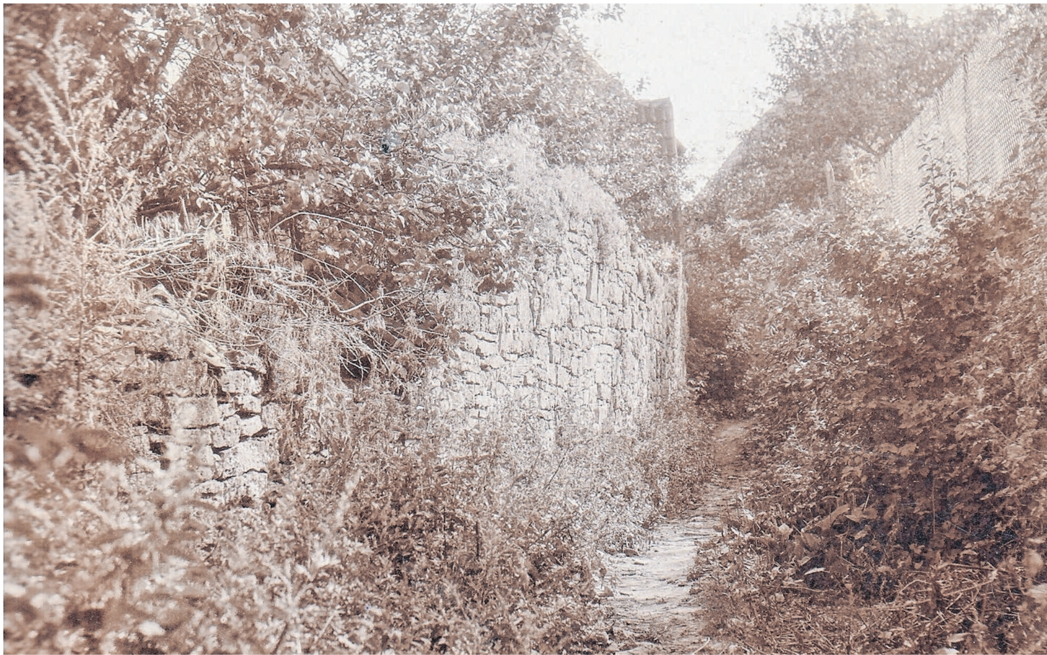
Steinfeld war früher von einer bis zu drei Meter hohen Dorfmauer und vier „Thoren“ sowie im Westen durch den Hofgraben umgeben. Das Foto zeigt ein Stück der Dorfmauer (um 1930) unterhalb der Würzburger Straße. Heute stehen davon nur noch Reste.
